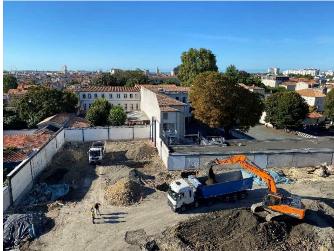
Chargement direct des déblais lors de l'excavation
