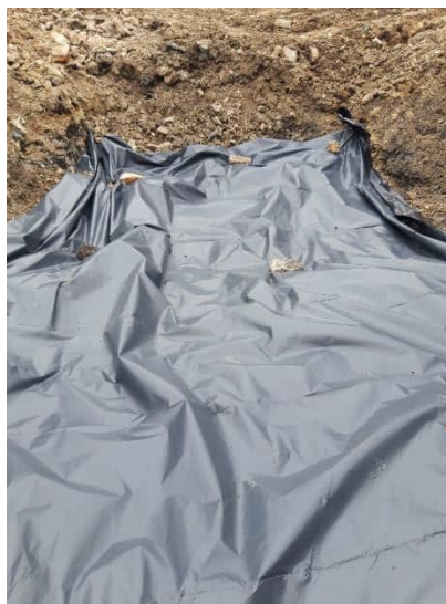
Recouvrement de fouille
